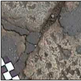
Figura 13: Asportazione di sigillante dai giunti
