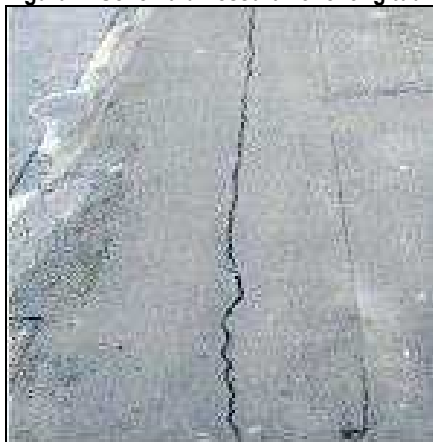
Figura 7: Schema di fessurazione longitudinale
