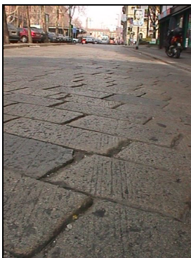
Figura 12: Eccessiva apertura dei giunti non sigillati
