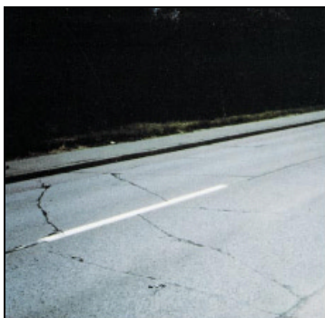
Figura 3: Esempio di fessurazione trasversale
