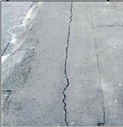
Figura 8: Esempio di fessura longitudinale
