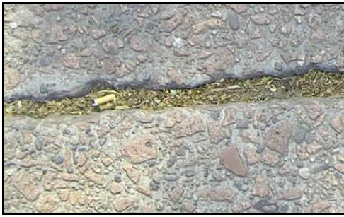
Figura 4: Degrado dei giunti non sigillati
