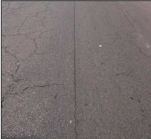
Figura 11: Fessura longitudinale da giunto di stesa.
