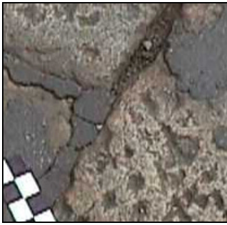
Figura 13: Asportazione di sigillante dai giunti
