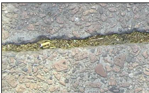
Figura 4: Degrado dei giunti non sigillati
