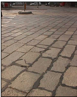
Figura 14: Spandimento di legante sul massello
