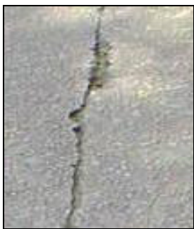
Figura 2: Esempio di fessurazione longitudinale
