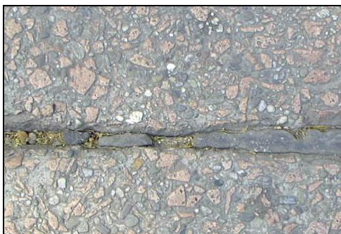
Figura 5: Degrado dei giunti precedentemente sigillati
